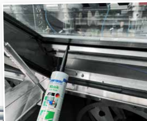
Kleben und dichten einer Glasabdeckung (Olivenverarbeitungsmaschine) | Flex 310 M® Klassik
